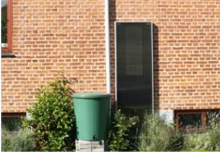
Liegt die Kellerdecke oberhalb des Erdreichs, kann der Warmluftkollektor meistens direkt und mit geringstem Aufwand an die Außenwand montiert werden.
