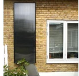
Falls der Keller zu tief liegt, kann ein zusätzliches Lüftungsrohr als Verlängerung eingesetzt werden.
