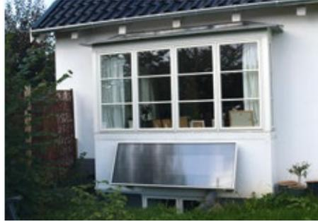
Bei angeneigter Montage kann der Warmluftkollektor im Sommer eine höhere Temperatur erzeugen - und damit eine bessere Entfeuchtung liefern.
